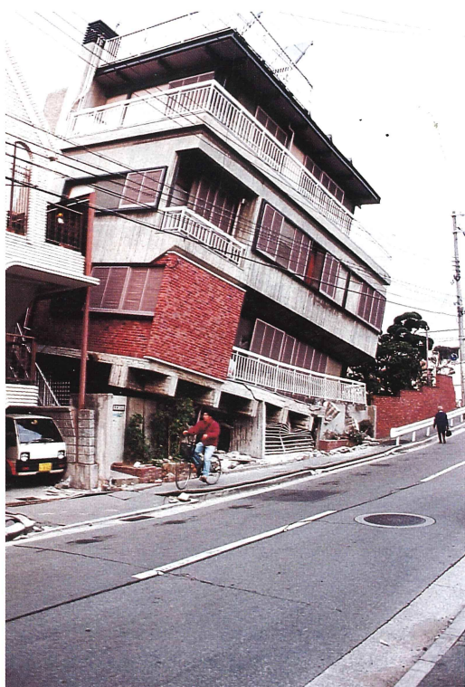
写真5 1階の車庫入口が潰れた 4階建て(西宮市相生町)
