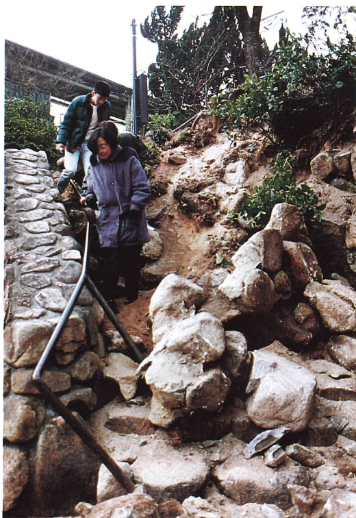
写真15 石垣が崩れ、堤防上の公園と並行する道路とを結ぶ石段が埋まっている（西宮市大井出町）
