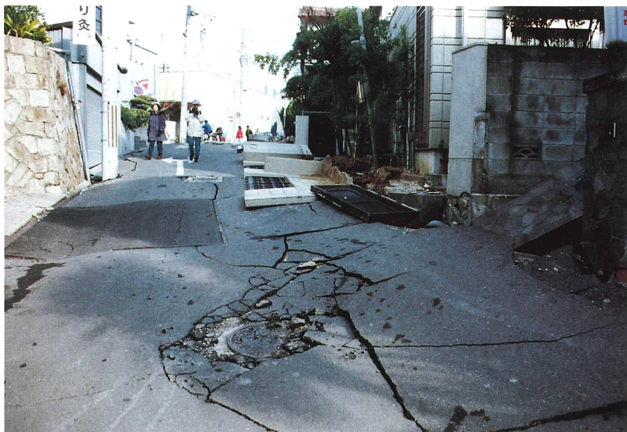
写真10 谷戸筋に当たる坂道、マンホールと舗装のズレに注意（西宮市松生町）
