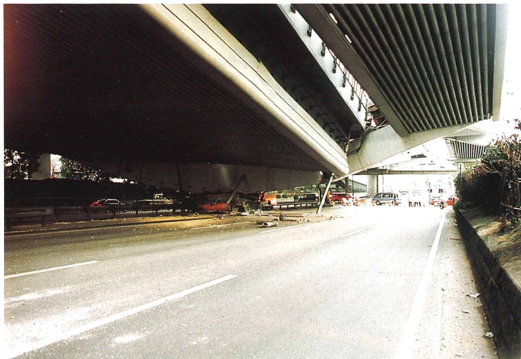
写真4 押し潰された鉄骨橋脚、右手のやや明るい部分が建石交差点
