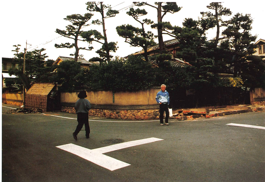
写真6 左手の門は西側に倒れ、右手の煉瓦塀は北側に植木が並んでいたためか南側に倒れている（芦屋市平田町）
