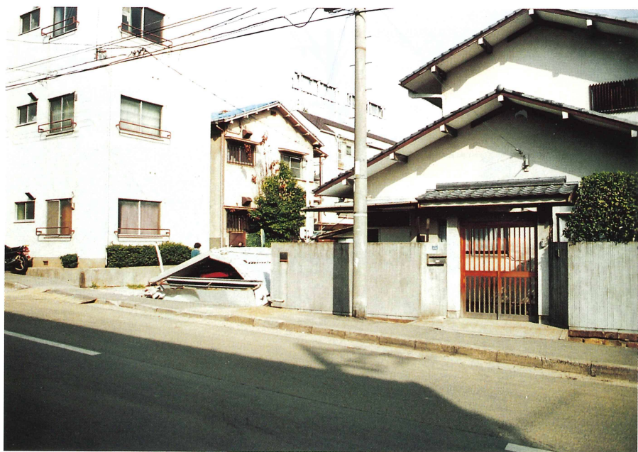
写真29 家はもったが左手の車庫は倒れ、車は潰れた (東灘区西岡本3丁目：1月28日撮影)
