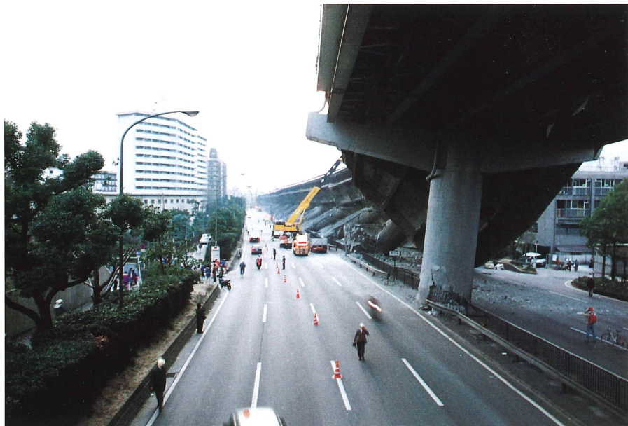
写真2 歩道橋上から（芦屋市平田町）
